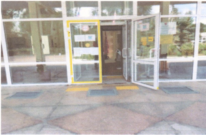
Фото 11 Входная площадка входа №2
