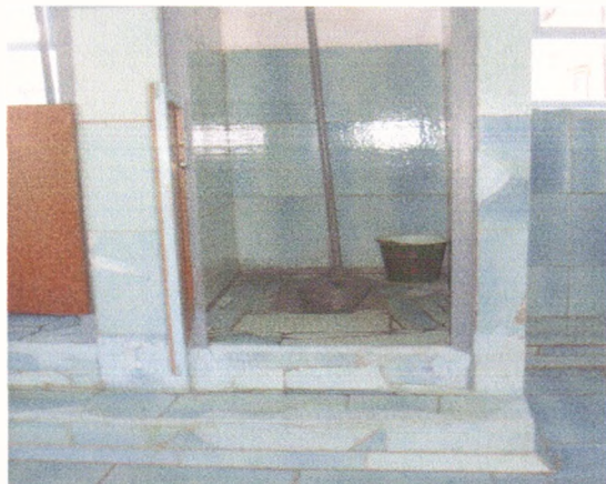
Фото № 33 – Санитарно-гигиеническое помещение (3 этаж)
