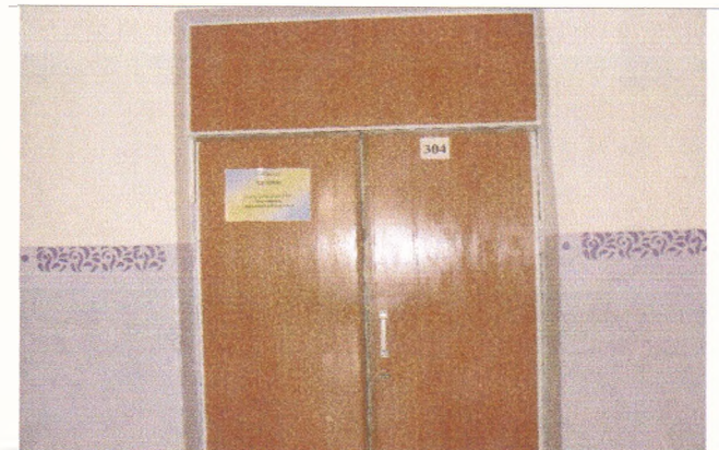
Фото № 21 – Пути движения внутри здания (двери)
