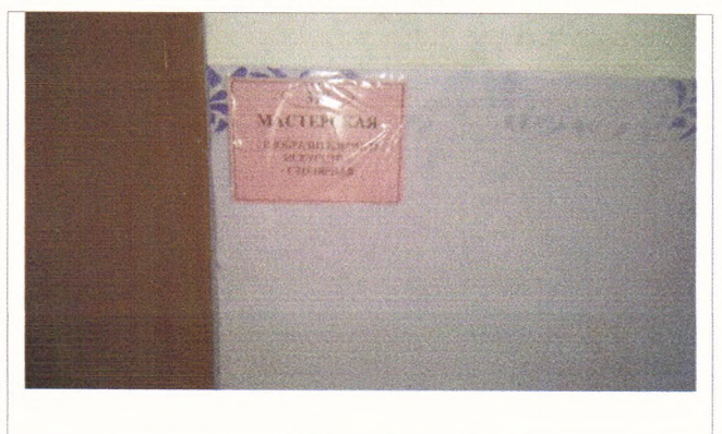
Фото № 20 – Пути движения внутри здания (двери)
