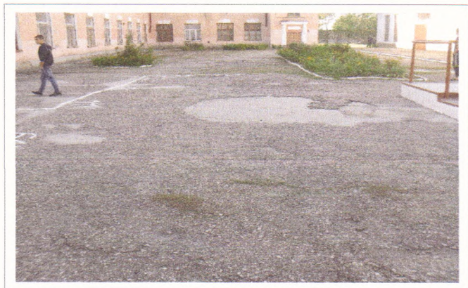
Фото № 3 – Прилегающая территория ( двор )
