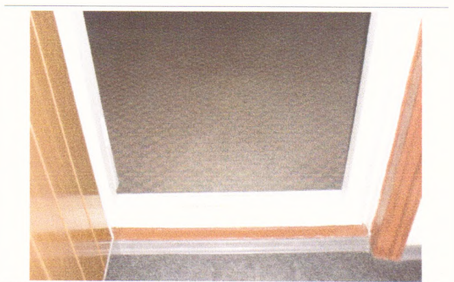
Фото № 22 – Пути движения внутри здания (двери)
