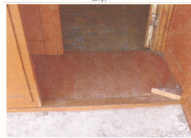
Фото № 10 Вход в здание № 4 (тамбур)
