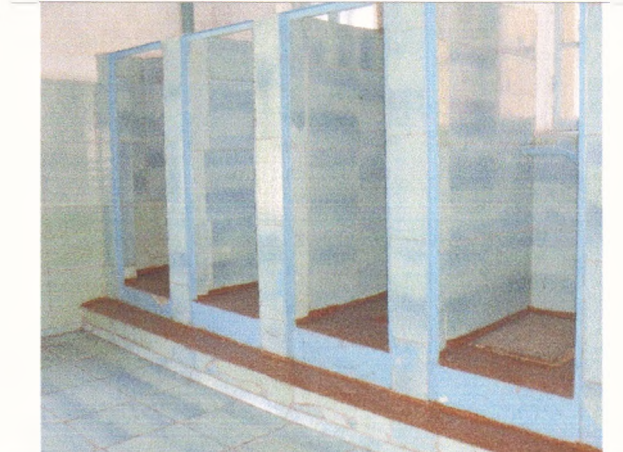
Фото № 30 Санитарно-гигиеническое помещение ( 2 этаж)
