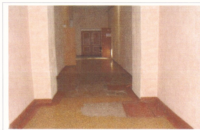
Фото № 12 - Пути движения внутри здания (коридор)
