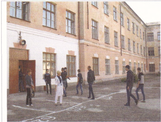
Фото № 8 – Вход в здание № 4 (вспомогательный с выходом во двор)
