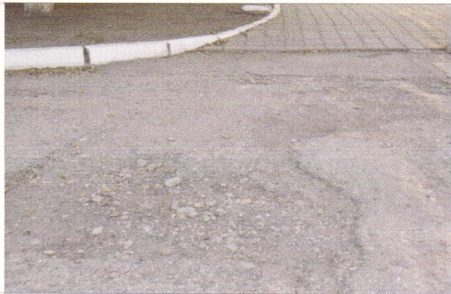
Фото № 43 - Пути движения от остановки транспорта
