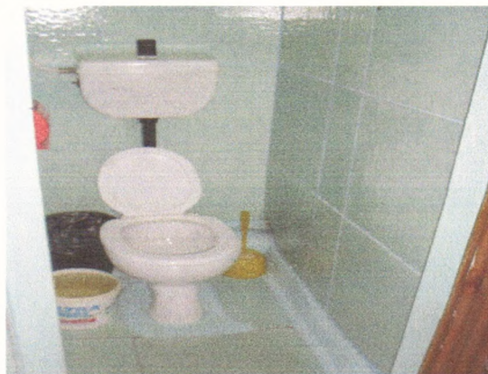
Фото № 32 – Санитарно-гигиеническое помещение ( 2 этаж)
